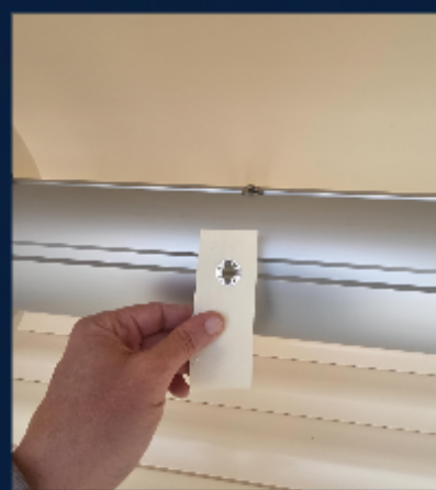
4. Positionner les écrous face aux sangles
