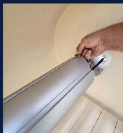
3. Insertion des Écrous carrés
