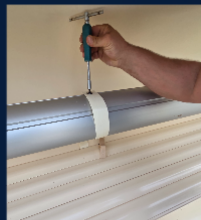
4. Positionner les écrous face aux sangles
