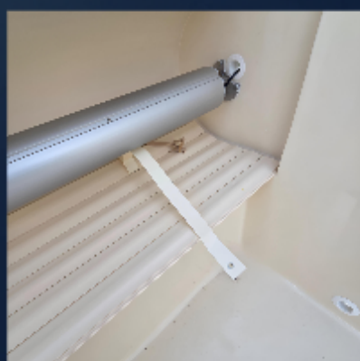
1. Pose de la lé de 6 lames
