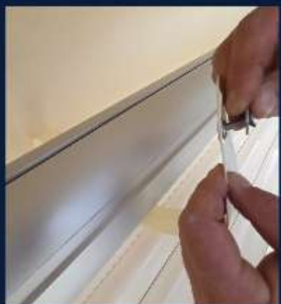
5. Psser les vis dans les œillets
