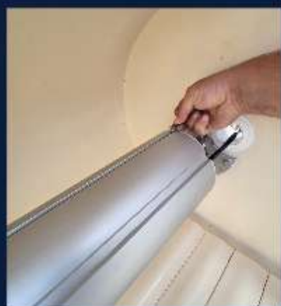
3. Insertion des Écrous carrés
