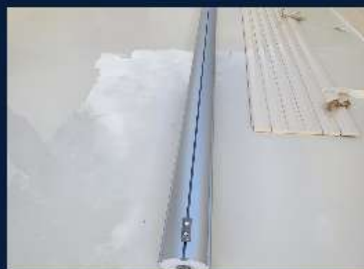
Lés de 6 lames et sangle de liaison avec l'arbre
