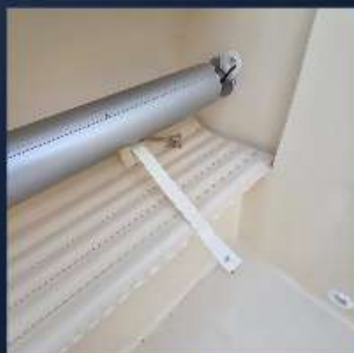
1. Pose de la lé de 6 lames
