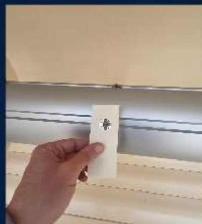
4. Positionner les écrous face aux sangles
